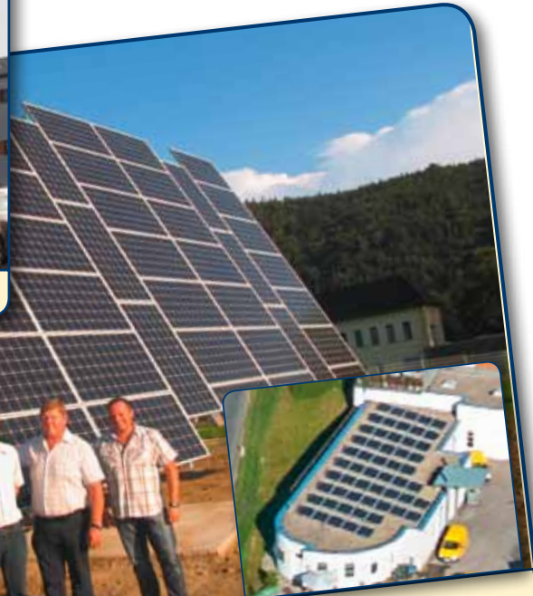
Wir nutzen die Sonnenenergie -Zwei Photovoltaikanlagen gingen im Herbst 2012 im Betrieb Für die Kläranlage Weins wurde eine nachgeführte und für das Gemeindezentrum ein fixe Anlage von der Firma Wüsterstrom montiert. Die nicht benötigte Energie wird ins Stromnetz gespeist.
