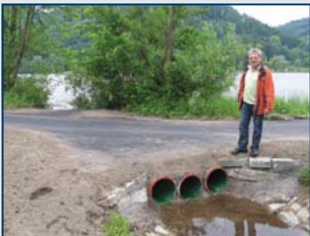
Der Radweg ist nun saniert
